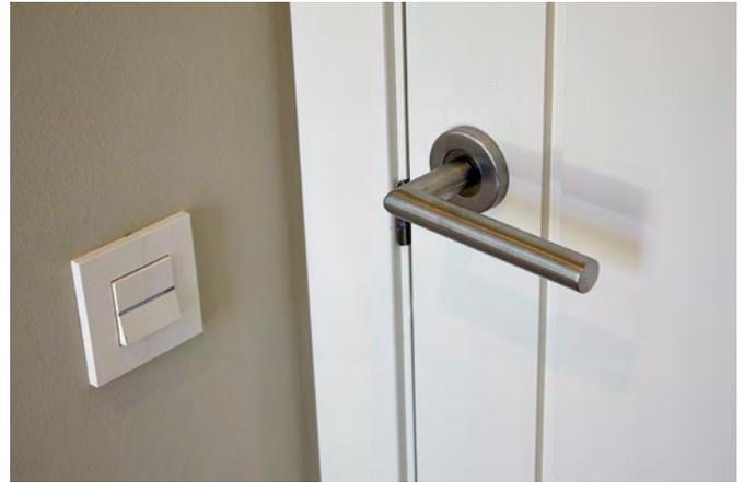
Revestimientos de premarco mediante jambas y tapajuntas sin claveteado.
