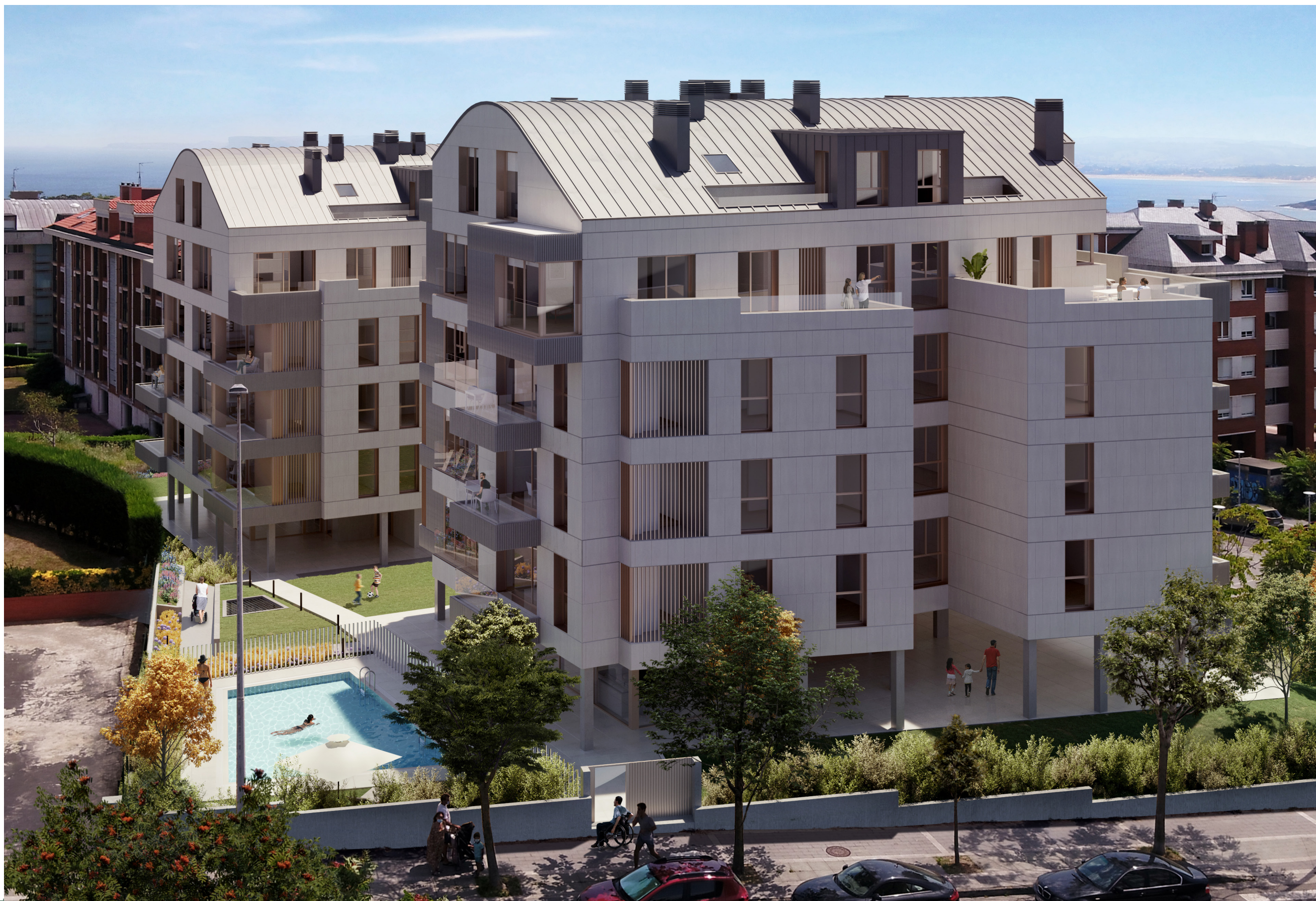
Vista fachada lateral y piscina
