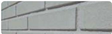
El cerramiento está formado por una doble hoja de medio pié de ladrillo cerámico a cara vista por el exterior y un trasdosado de doble placa de cartón yeso de 13 mm sobre estructura de acero por el interior. Entre ambas hojas dispondrá de un aislamiento a base de lana de roca mineral de 70 Kg/m<sup>3</sup> de densidad, asegurando un gran confort térmico interior.
