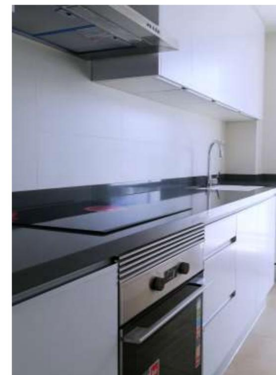
**Fregadero** de fibra de un seno encastrado bajo encimera marca Sintetika o similar, de 54 cm de ancho.
